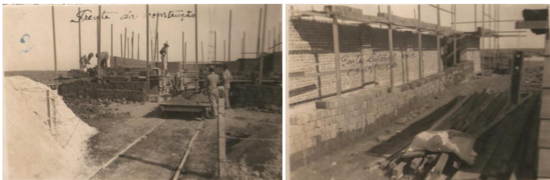
Figura 26: Fotografias da construção da Igreja no ano de 1946. Fonte: 1º Livro ata da Igreja Nossa Srª da Paz.
