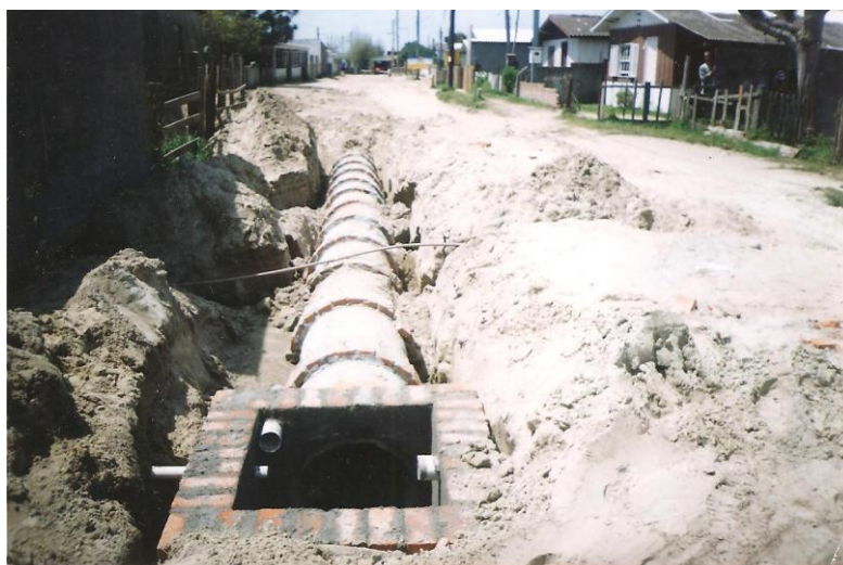
Figura 11: Construção do canaleta da Rua 11. Fonte: João Dutra, em 2006.
